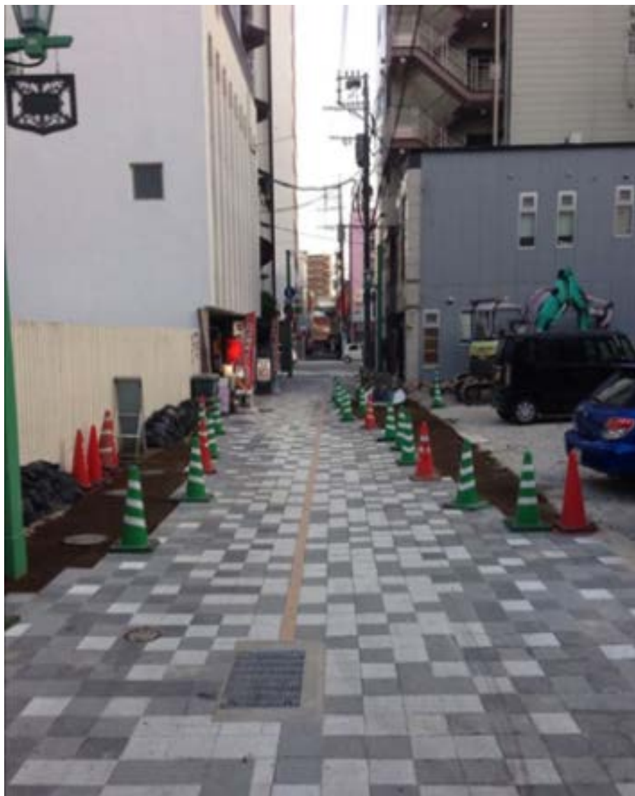
アーケードの撤去と路面改装
