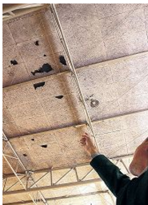
2012.11.25 輪島市上野台中体育館 天井崩落
