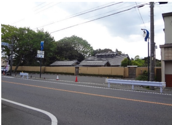
国道一号線から
