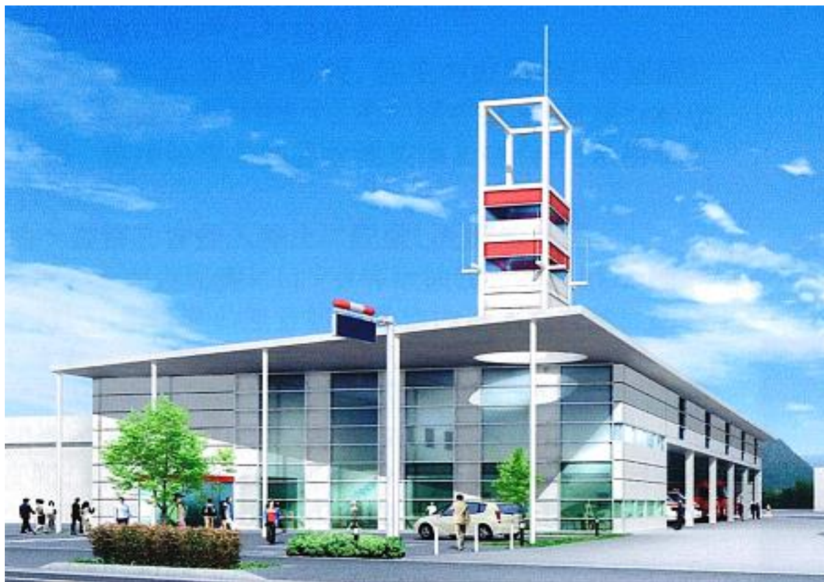
消防庁舎正面外観
