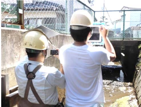
タブレットを用いた直営点検
