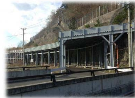
大倉シェッド【昭和38年建設】
