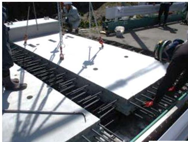
①床版の設置
