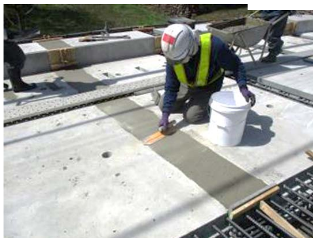
③間詰めコンクリート打設 (防水仕様)
