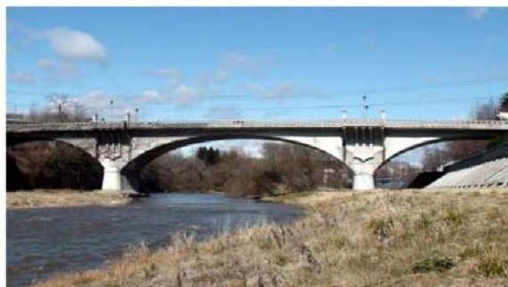
大橋【昭和13年架設】
