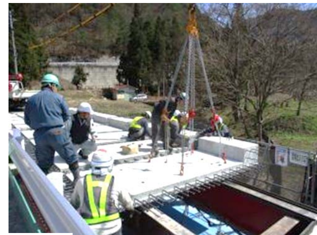
②床版の設置
