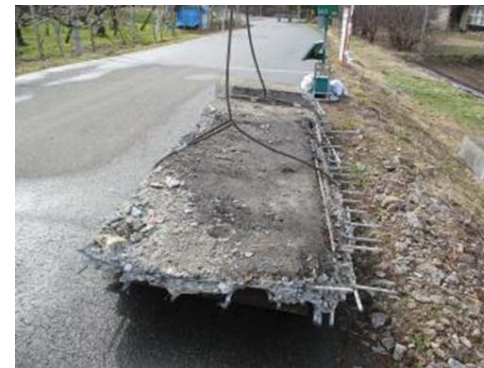
床版撤去時の状況（損傷程度を調査・評価）
