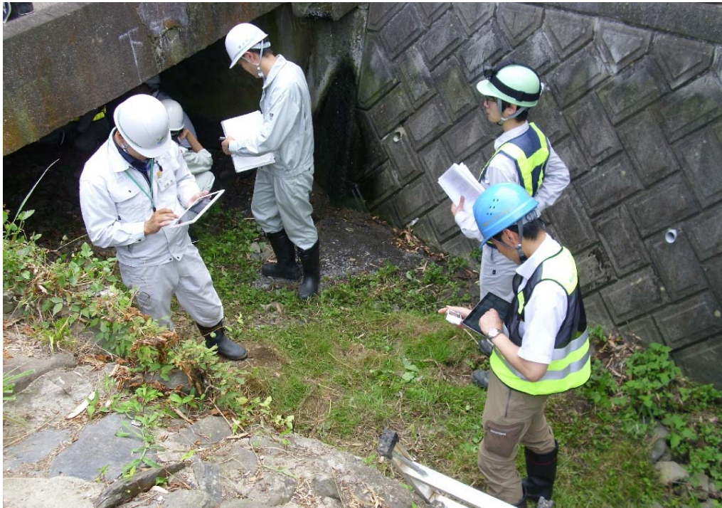
タブレットを利用した 現場直営点検の効率化検討
