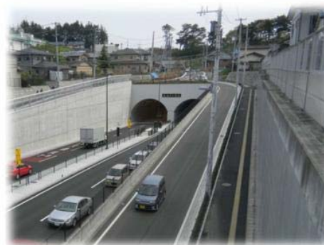
北山トンネル【平成23年建設】
