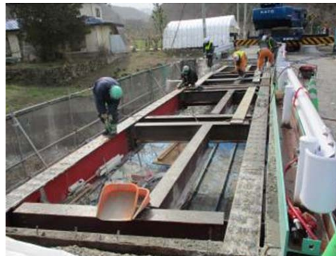
床版撤去時の状況（損傷程度を調査・評価）
