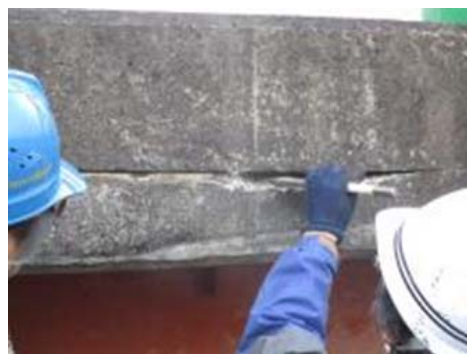
② 浮き箇所のはつり
