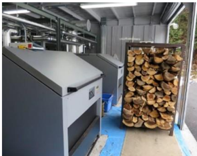
写真 薪ボイラー
