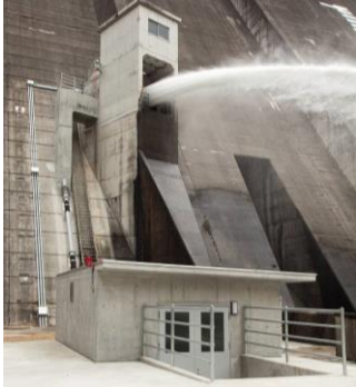
【発電設備の新設・増強】
