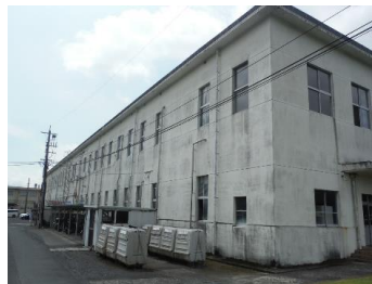
【現状施設の例(庁舎)】
